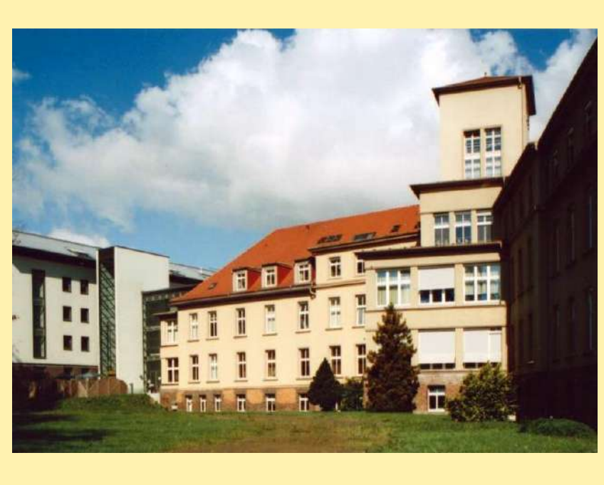
Haus 2 Ansicht von der Weinuallee
